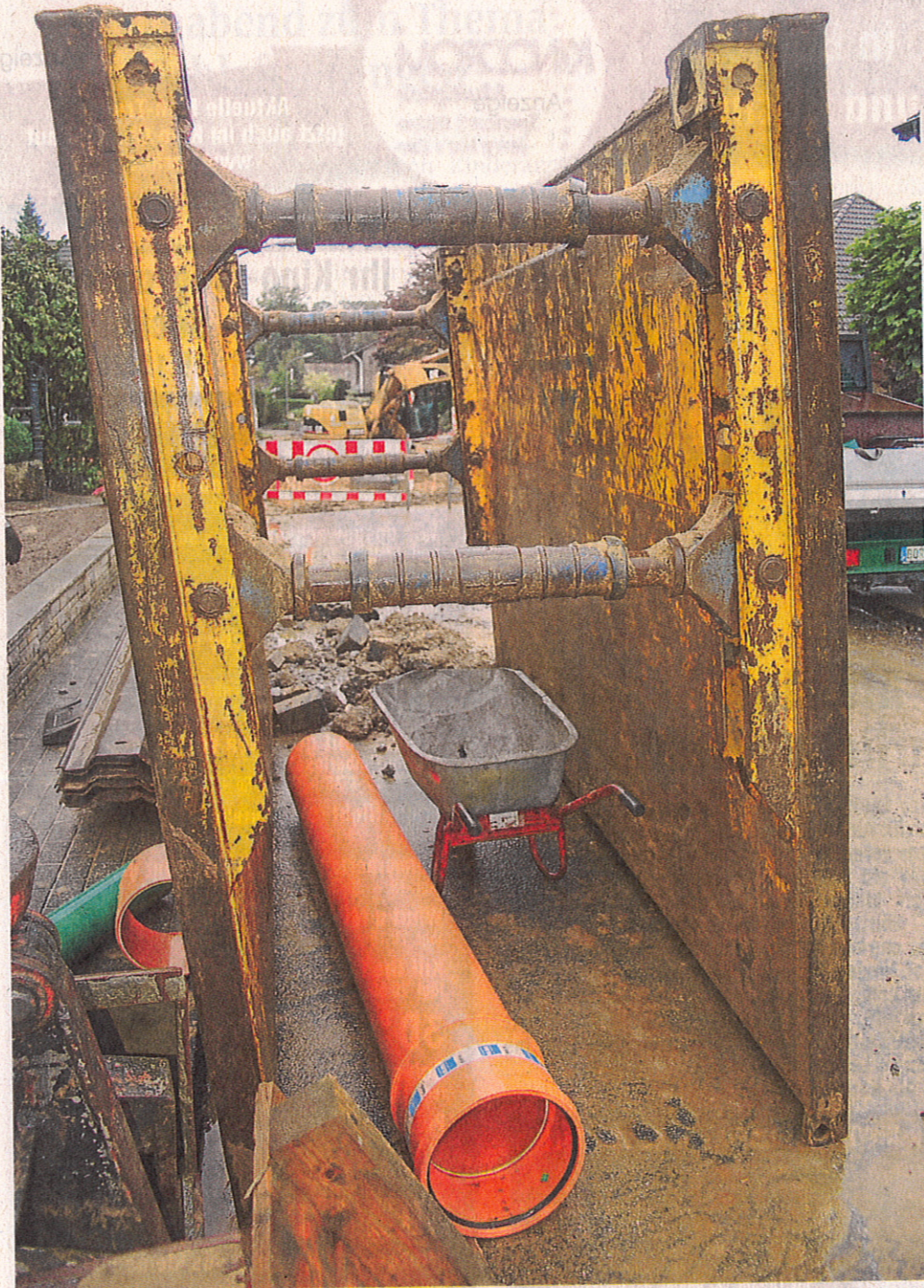
Im Knufdrees wird derzeit mit schwerem Gerät gearbeitet.
